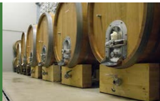
Perfekte Kellerhygiene dank nahtlos an Rinnen und Wände anschließender Spezialböden
